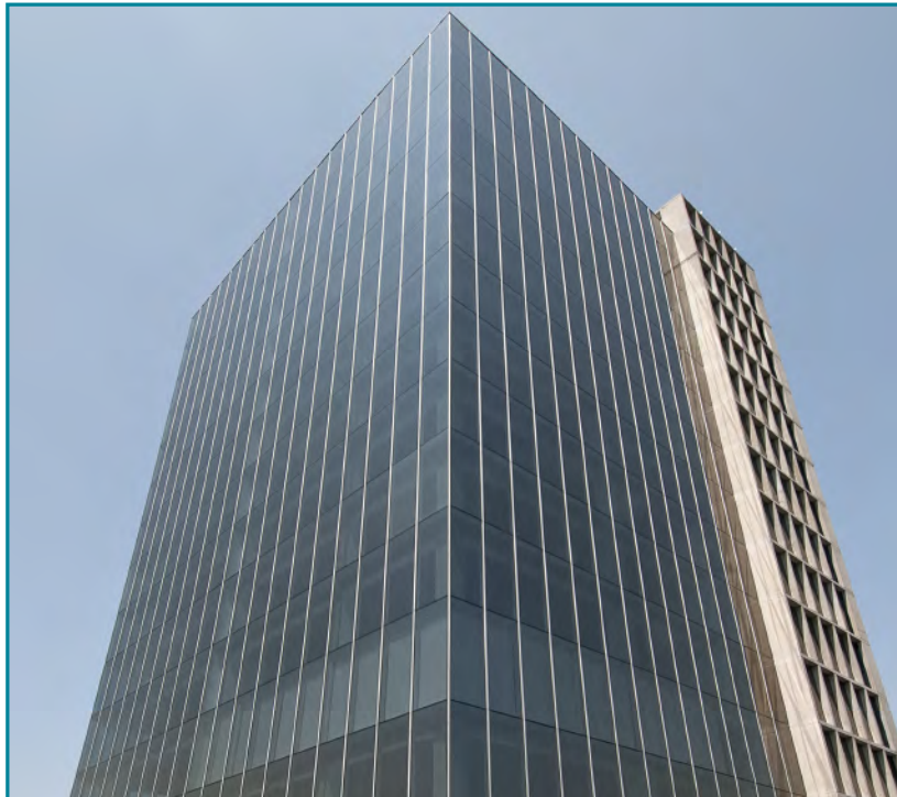
Obra: Edificio Vespucio Córdova Cristal: Cool – Lite KNT 140 Instalador: Estructuras Arquetipo
